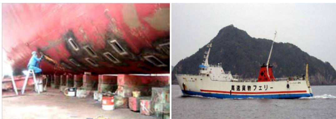
Figura 29: Installazione di 20 ulteriori dispositivi WAIP sul traghetto New Ferry Misaki.
