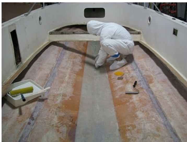
Figura 4: Laminazione manuale in una piccola imbarcazione [2].
